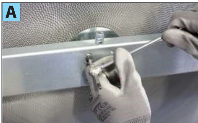
1) Die 4 Schrauben lösen (Foto A)
