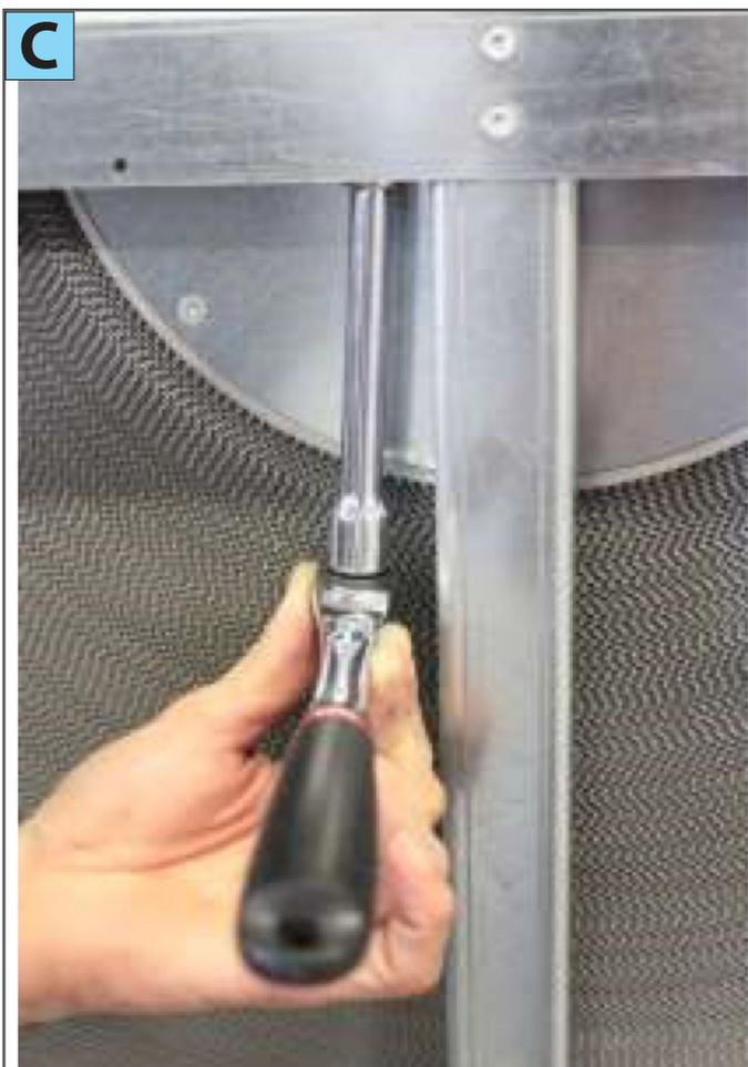
1) Desaperte os dois parafusos (foto C)
